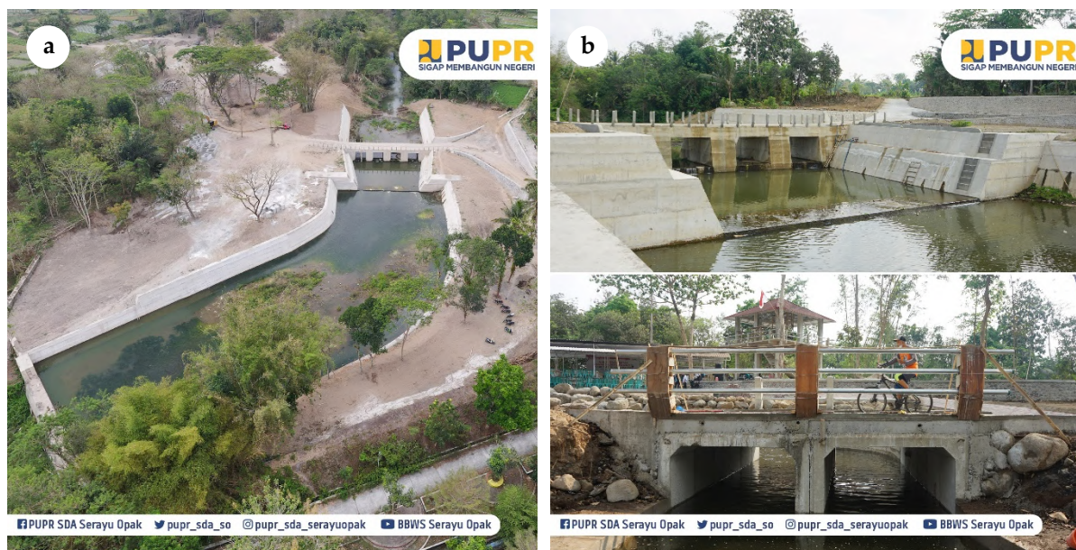
Gambar 3. Pembangunan sabo dam Pakunden: (a) Sabo dam tampak atas; dan (b) Kawasan pengembangan wisata (Balai Besar Wilayah Sungai Serayu - Opak, 2023)
