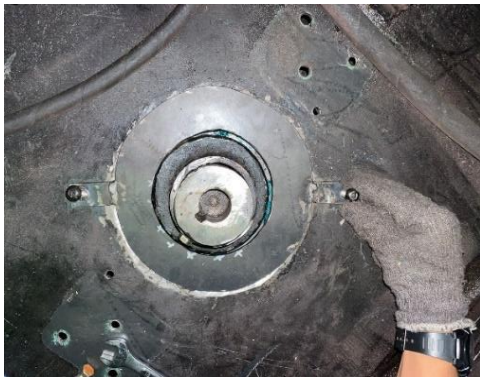
Gambar 13 Pemasangan cover penutup
