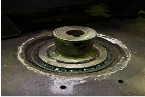
Gambar 11 Pemasangan Tapper bearing pada housing bearing
