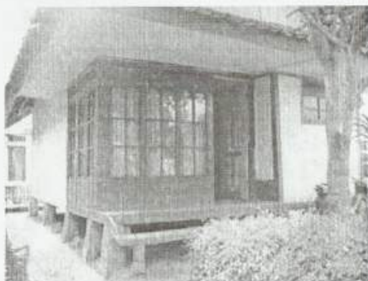
Gambar 8. Salah satu rumah panggung kayu di Desa Jaya Pura yang tetap kokoh saat gempa bumi
