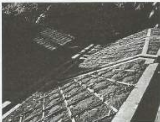
Gambar 7. Bangunan terasering sebagai model percontohan dalam upaya penanggulangan tanah gerak di Dsn Gandusari, Ds. Cibangkong, Kec. Pekuncen, Banyumas
