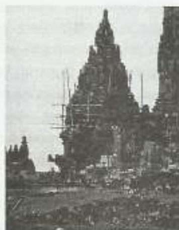
Gambar 1. Kerusakan candi Prambanan akibat bencana gempabumi Yogyakarta dan Jawa Tengah 2006 (dok. PSBA, 2006)
