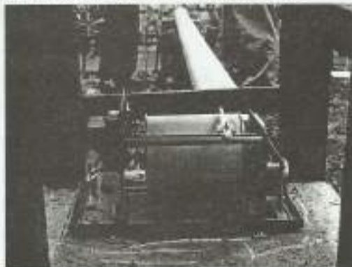
Gambar 2. Ekstensometer otomatis yang dipasang di Desa. Cibangkong
