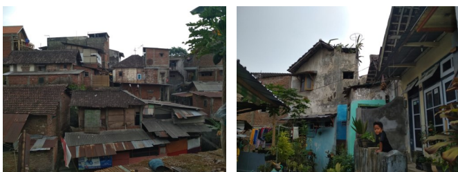
Gambar 1. Kawasan Permukiman Kumuh Kota Malang (Sumber: Dokumentasi Lapangan, 2020)
