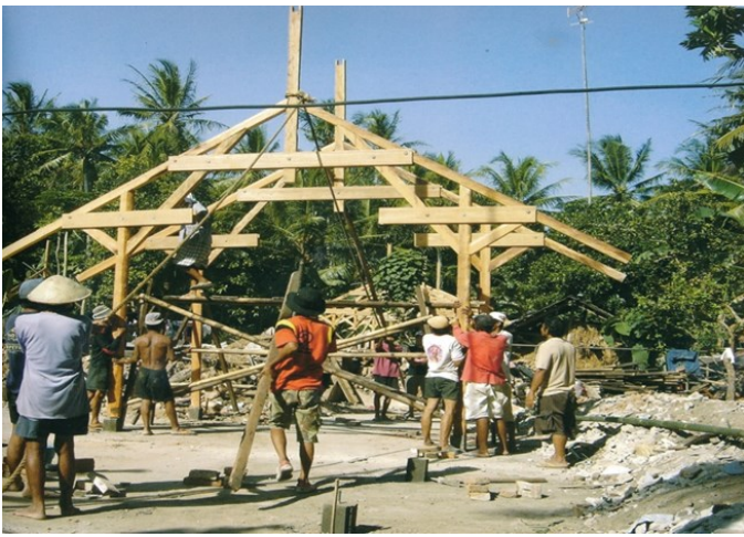
Gambar 2. Warga gotong royong membangun kembali rumahnya (Sairin, dkk., 2008)
