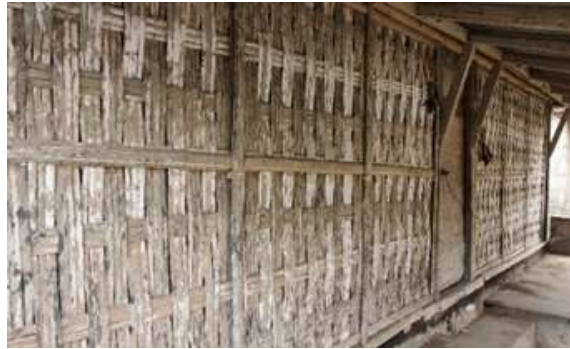
Gambar 4. Perubahan Material Pada Bale-Bale Bambu di Desa Pengotan (Sumber: Google Image,2021)
