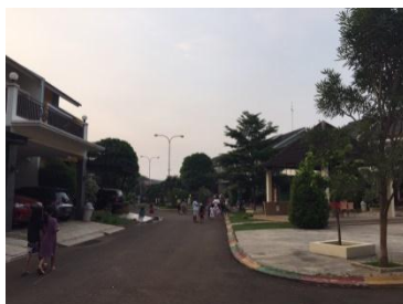
Sumber: Data primer diolah (2017) Gambar 5. Perkerasan di taman
