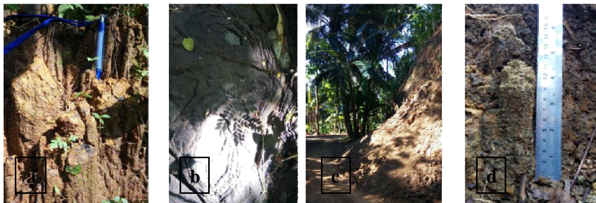
Gambar 4. Splash Erosion (a); Pelapukan mengulit bawang (b); Kejadian longsor (c); dan Struktur Columnar (d)
