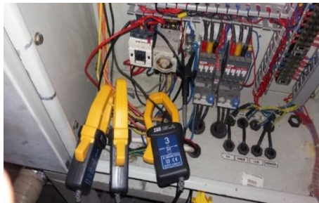
Gambar 7. Pemasangan alat ukur arus listrik
