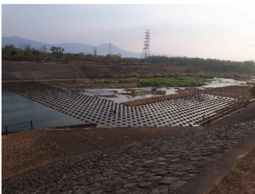
Foto 2. Struktur Bendung Colo (Tim PKM Pengkol)
