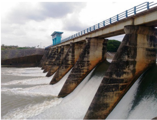
Foto 1. Pintu air Bendung Colo (Tim PKM Pengkol)
